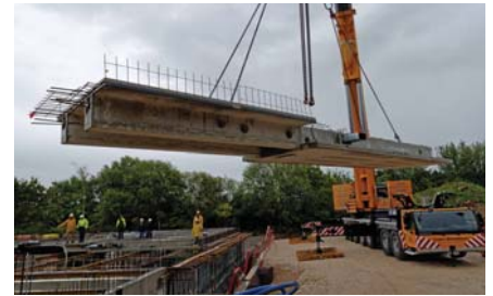
Prosis, Gaimersheim: thermisch aktivierte Decke inkl. integrierter Lüftung, Akustik, Beleuchtung; Bauherr: The Wyberal Company GmbH, Rohrbach.
