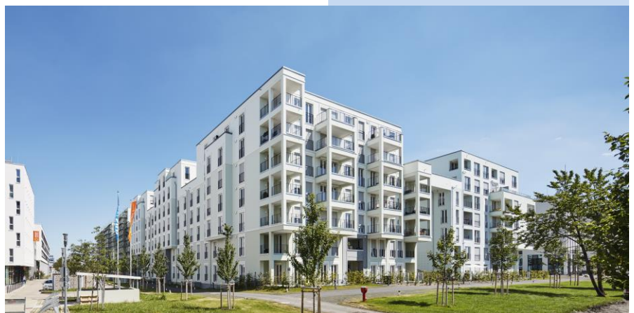
Wohnanlage Olympia Wohn Park, München: schlüsselfertiger Neubau von sechs Häusern mit 127 Eigentumswohnungen und Tiefgarage inkl. Außenanlagen und Ausführungsplanung.
